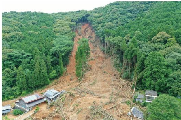
大雨による山腹崩壊（熊本県芦北町）
