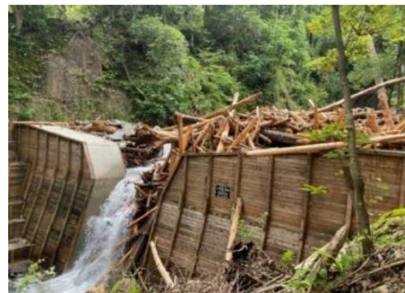
流木捕捉式ダムによる流木・土砂の捕捉 （熊本県球磨村）
