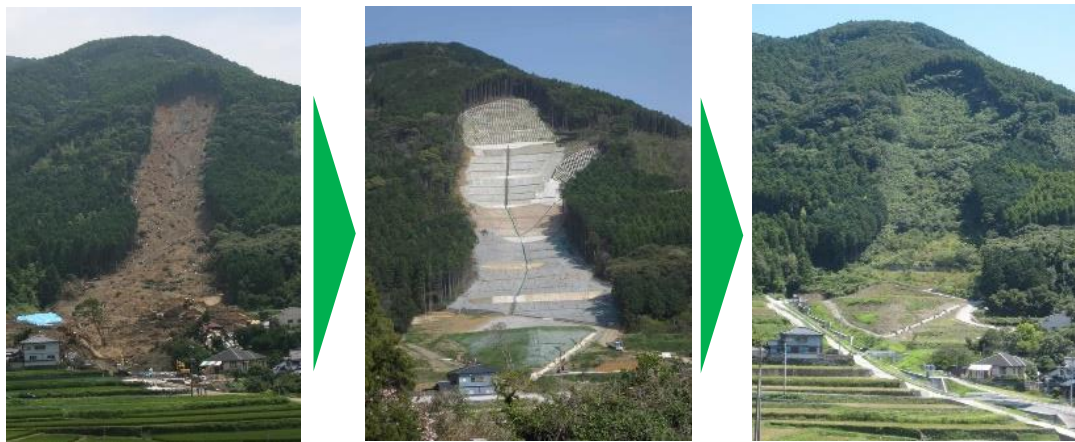
治山事業による災害復旧の経過（福岡県田川郡福智町）
